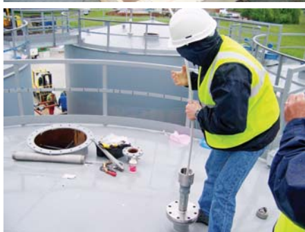
Монтаж уровнемера Veeder-Root для высоких резервуаров
